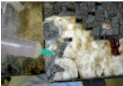
Consolidamento dello strato d'allettamento con resina acrilica in emulsione acquosa, veicolata con una soluzione di acqua e alcool. Protezione dei ferri dell'armatura con infiltrazioni di una resina acrilica in solvente applicata in concentrazioni differenziate dal 5 al 15%.
