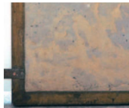
Il mosaico è supportato da pannelli in cemento armato, ideati e realizzati appositamente per l'opera. Si tratta di una serie di pannelli contenuti da un telaio metallico in ottone, il quale incornicia il supporto fino alla superficie tessellata, tramite dei profilati a sezione di forma a L. Tutti i pannelli erano vincolati fra loro da delle fasce metalliche poste sul retro.
